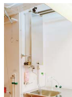
Module Pharma-X installé pour le refroidissement au point de prélèvement chez AstraZeneca, Suède.
